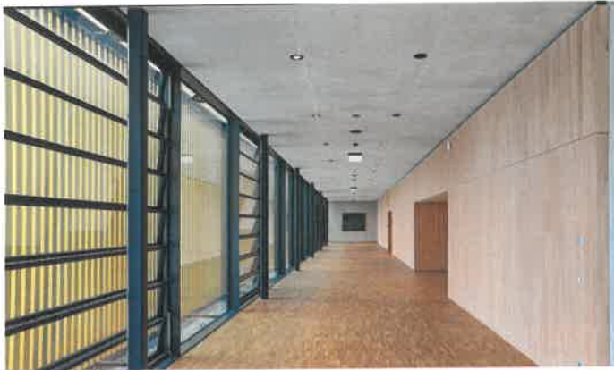
/ Weißtanne veredelt den Innenraum der Stadthalle in Cham: Als Decken- und Wandverkleidung wurden die Leistenpaneele Ligno-Akustik-light eingesetzt.
