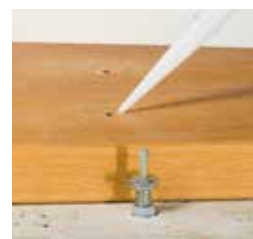
Encoller et monter
