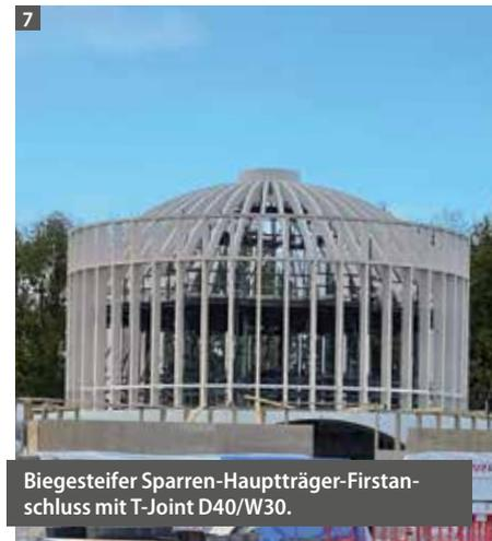
Biegesteifer Sparren-Hauptträger-Firstanschluss mit T-Joint D40/W30.
