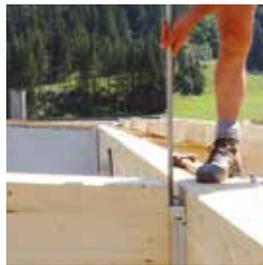
**13:08** | Gewindestangen einlegen und in Spannbacke eindrehen.
