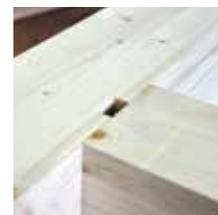
Gesicherte Verbindung durch Sperrbügel
