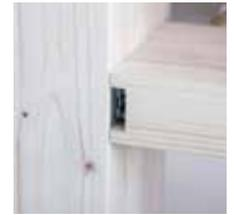
Gesicherte Verbindung durch Sperrbügel
