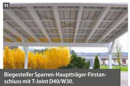
Biegesteifer Sparren-Hauptträger-Firstanschluss mit T-Joint D40/W30.
