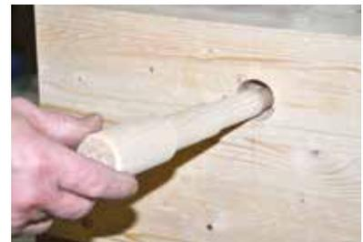
Einsetzen bis zum Nagelkopf.
