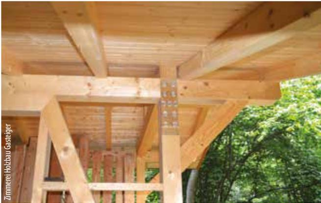
T-JOINT D35/W30 befestigte Laubholzlaschen von BSH-Zugstößen.
