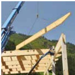
**13:00** | Nach Ausrichten des Binders wird der MEGANT® eingehängt.
