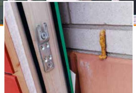
Montagebeispiel: Montiert an Wandelement mit beidseitigen Dichtungen.
