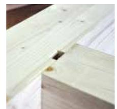
Gesicherte Verbindung durch Sperrbügel.
