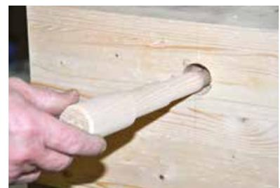
Einsetzen bis zum Nagelkopf.
