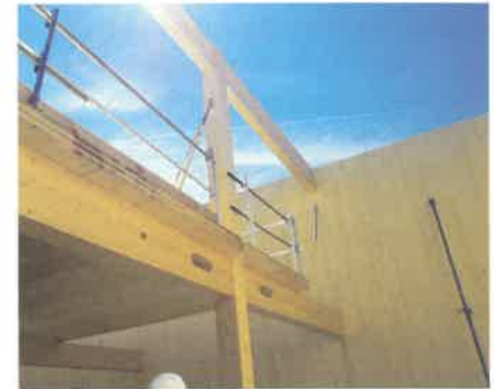
▲ Alle zwölf Arbeitstage stellte das achtköpfige Mitarbeiterteam eine neue Etage fertig
