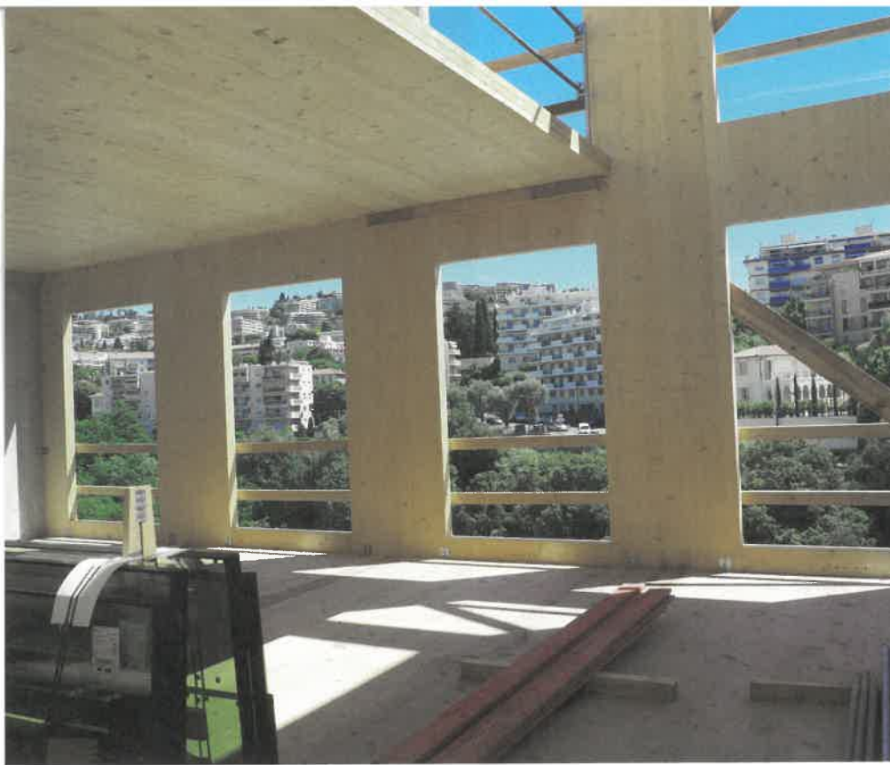
▲ Die Holzständerkonstruktion setzt auf Brettschichtholz, in den Fassaden und für die Decken kamen Brettsperrholzelemente zum Einsatz
