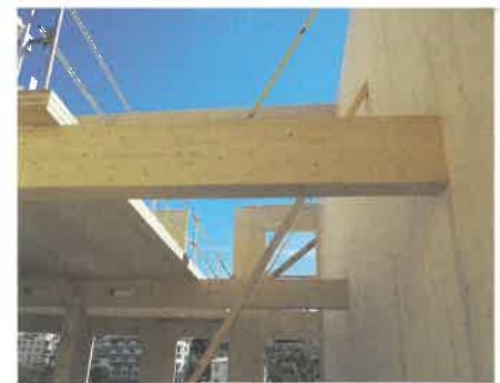
▲ Die Brettsperrholzdecken wurden auf die Unterkonstruktion aufgelegt
