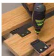
Positionner et pré-percer avec le gabarit
