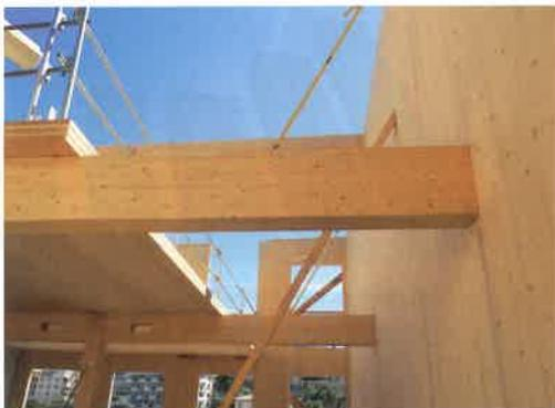
Die Träger wurden im Zuge der Vorfertigung mit insgesamt 400 „Ricon® S“ vormontiert
