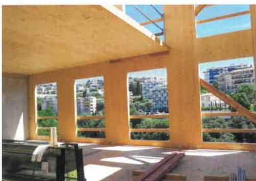
Nach dem Einhängen der Haupt- und Nebenträger konnten direkt die BSP-Decken auf die Unterkonstruktion aufgelegt werden (Fotos: Knapp)
