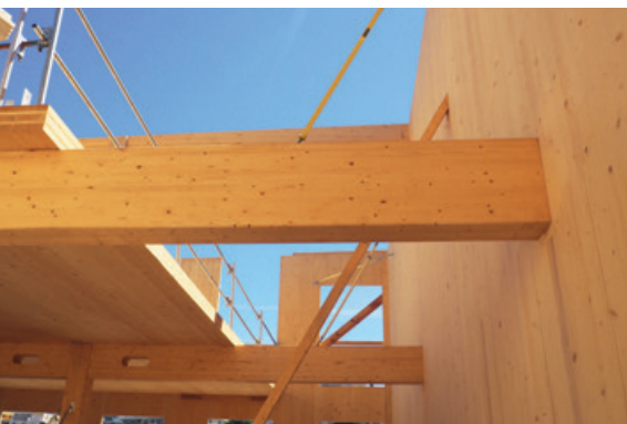
Nach dem Einhängen der Elemente sind die Verbinder nicht mehr sichtbar – sämtliche Haupt-Nebenträger wurden damit ausgeführt
