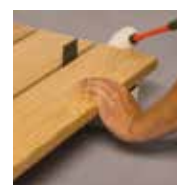
Abschlussdiele montieren
