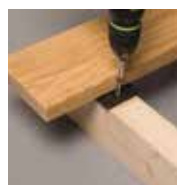
Verschrauben Lagerholz
