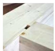
Assemblage sécurisé avec goupille de verrouillage.
