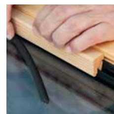
Keildichtung einpressen
