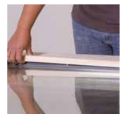
Einclippen der Glasleiste
