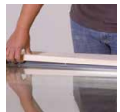
Einclipsen der Glasleiste
