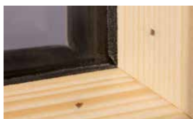
Herkömmlich befestigte Glasleiste mit sichtbaren Nägeln.
