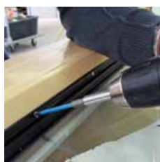
FIXclip-Schiene verschrauben
