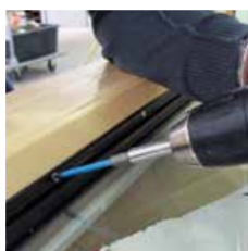
FIXclip-Schiene verschrauben
