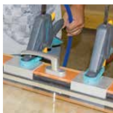
Scheibe gegen Außen-dichtung anpressen
