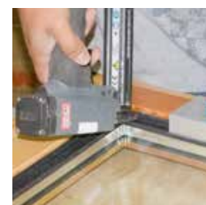
FIXclip-Schiene verschrauben oder nageln
