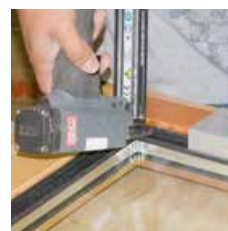
FIXclip-Schiene verschrauben oder nageln
