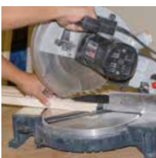
Glasleiste und FIXclip-Schiene zuschneiden
