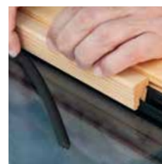
Keildichtung einpressen
