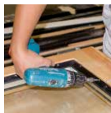
FIXclip-Schiene verschrauben oder nageln
