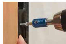
Verschraubung mit KNAPP® SK-Edelstahlschrauben 3,5x25 mm mit Bohrspitze
