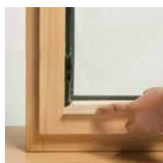
Einklipsen der Glasleiste
