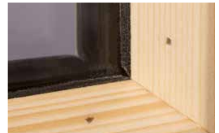
Herkömmlich befestigte Glasleiste mit sichtbaren Nägeln.
