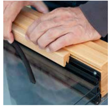
Anpressdruck über die Keildichtung
