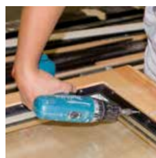
FIXclip-Schiene verschrauben oder nageln
