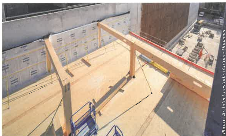
↑ Pose des poutres BL-C.
