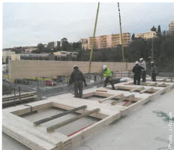
↑ Assemblage au sol des façades CLT.
