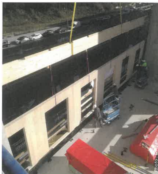
↑ Mise en place d'une façade.
