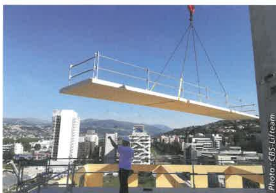
↑ Pose d'un plancher CLT.
