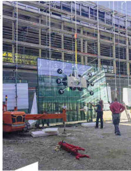
Bei der Montage der Fassadengläser erleichterte Hebetechnik den Einbau der schweren Scheiben.
