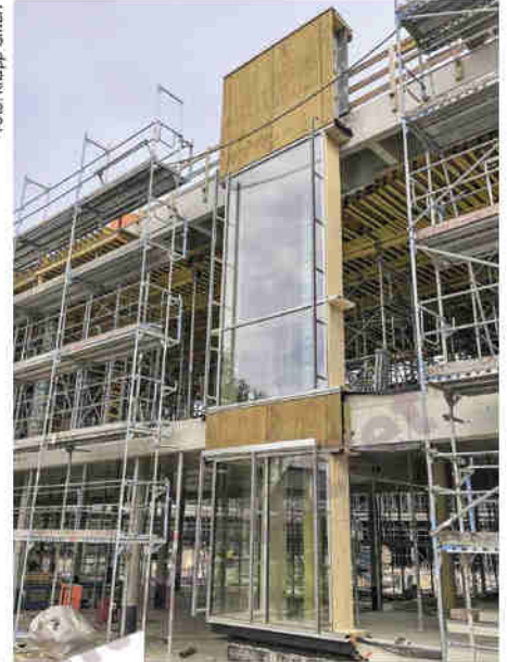
Hier ein fertiges Fassadenelement auf der Baustelle.
