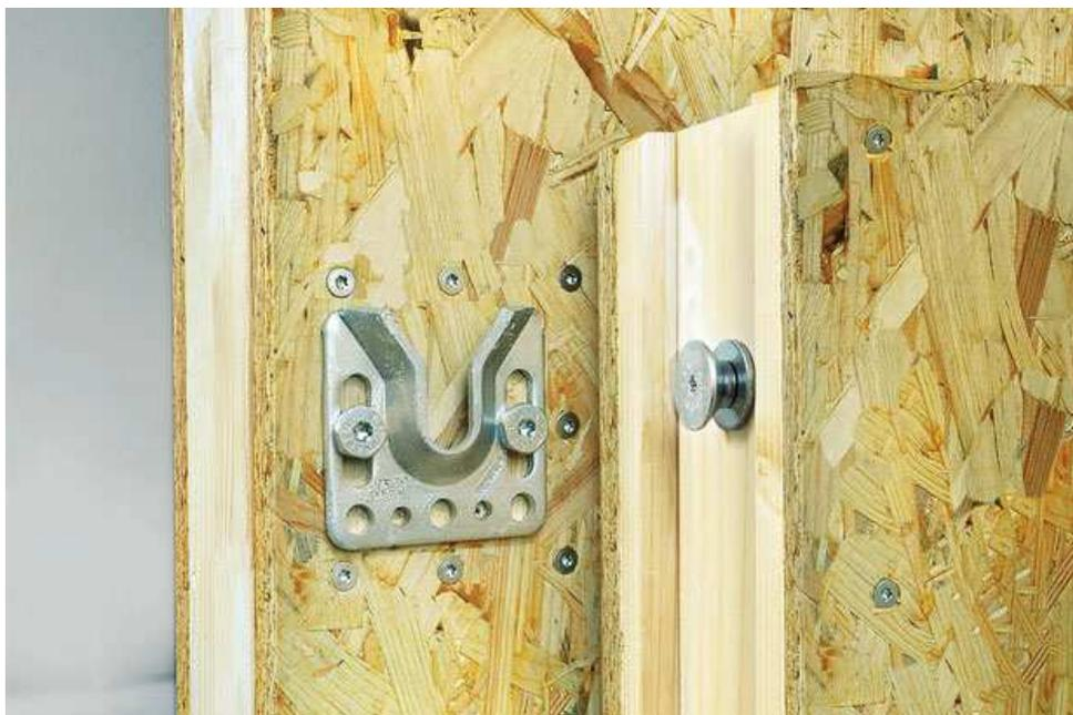
La ferrure Walco V à trous oblongs de Knapp permet l'assemblage efficace de murs avec une tolérance accrue pour la fixation.
