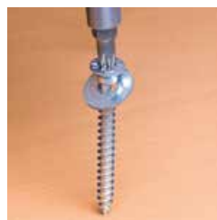
4) Schraube eindrehen
