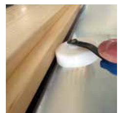
5) Leichte Verarbeitung mit Dichtungsroller
