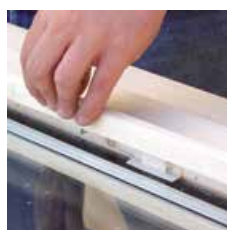
3) Glasleiste ansetzen
