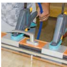
2) Scheibe gegen Außenabdichtung anpressen
