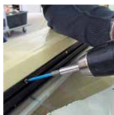
2) FIXclip-Schiene verschrauben
