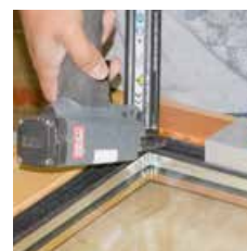
3) FIXclip-Schiene verschrauben oder nageln
