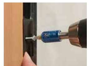
Anpressdruck durch 45° Schrägverschraubung
