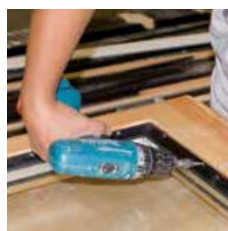
3) FIXclip-Schiene verschrauben oder nageln
