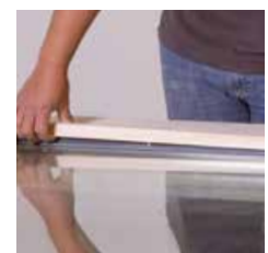
4) Einclipsen der Glasleiste
