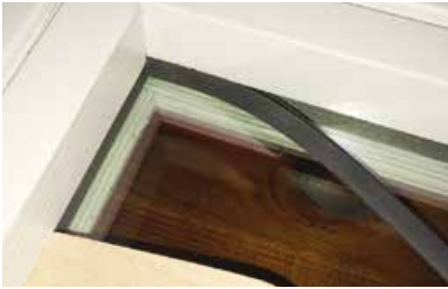
Montagebeispiel: Einbringen der Keildichtung
