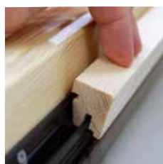
3) Einclipsen der Glasleiste
