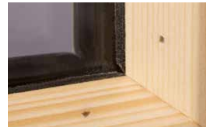
Herkömmlich befestigte Glasleiste mit sichtbaren Nägeln.
