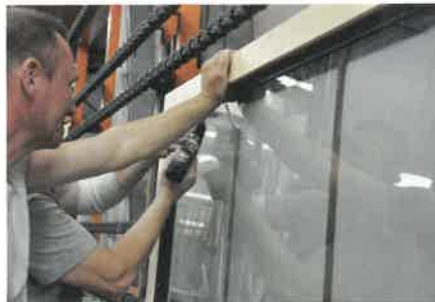
Anschließend werden die Schienen rundum im Flügel bzw. Rahmen verschraubt
