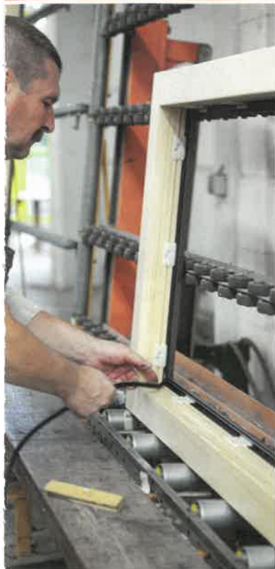
Beim Einglasen wird zunächst außenseitig Dichtband vorgelegt
