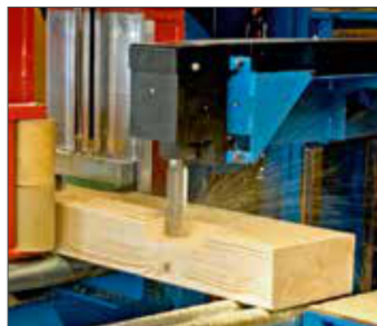
❶ Wyfrezowanie i wiercenie wstępne wykonane na centrum obróbczym
