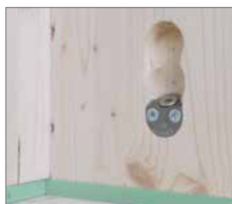
❸ Połączenie ścian z posadzką
