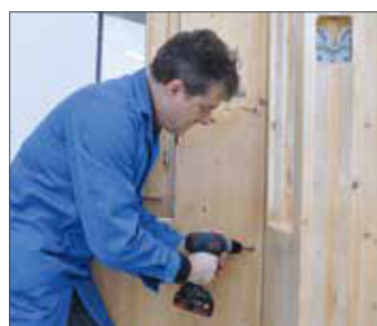
❷ Połączenie ścian na styk
