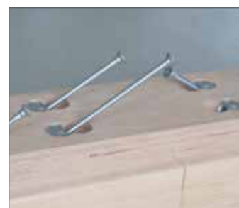
❹ Połączenie ze względu na rozciąganie
