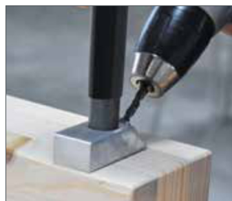
❸ Nawieranie wstępne przy użyciu szablonu do wierceń firmy KNAPP
