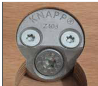
❸ Połączenie śrubowe pod kątem zakończone wkrętem SK Ø 8-12 mm
