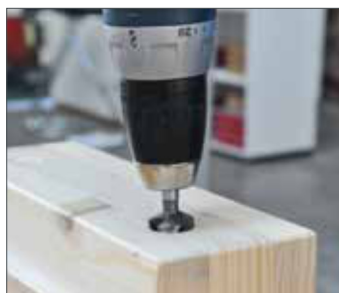
❷ Wiercenie pod złącze T-Joint 20 z ok. 2 mm pogłębieniem skośnym
