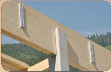
Exemple de montage : Vissage en applique sur porteur.
