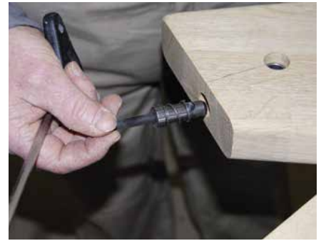
Einschieben des Verbinders. Die Feder vermeidet ein Spiel beim späteren Einstecken der Stufe.
