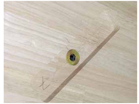
Die Schraube lässt sich später bequem in das Widerhaken­gewinde eindrücken.
