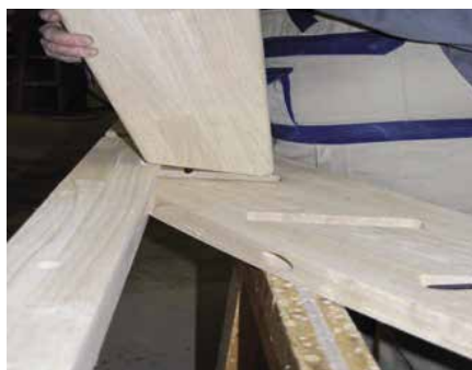
Diese Stufe lässt sich jetzt samt Gewinde in die Wange und Federmutter einschieben.
