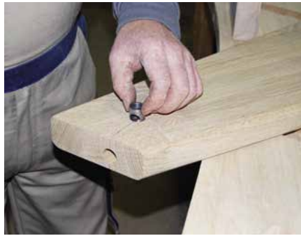
Einstecken der Befestigungshülse in das Sackloch an der Stufenunterseite.
