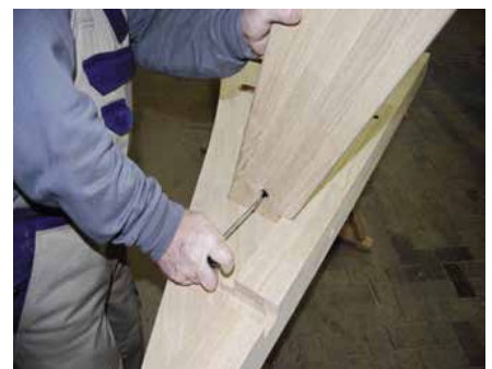
Mit dem Inbusschlüssel lässt sich die Stufe mit bis zu 600 kg festziehen.
