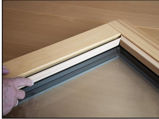
2. Restliche Glasleisten entnehmen und anschließend FIXclip-Schienen abschrauben.
