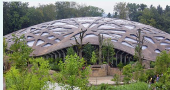
esb-Platten im Elefantenhause in Zürich: Rund 4000 m<sup>2</sup> wurden mit esb-Platten in der Dachkonstruktion verbaut
