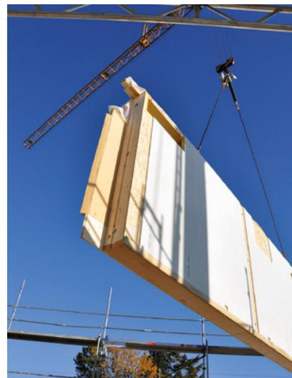
**Schnelle Montage:** In nur wenigen Augenblicken ist das Wandmodul durch Einhängen montiert
