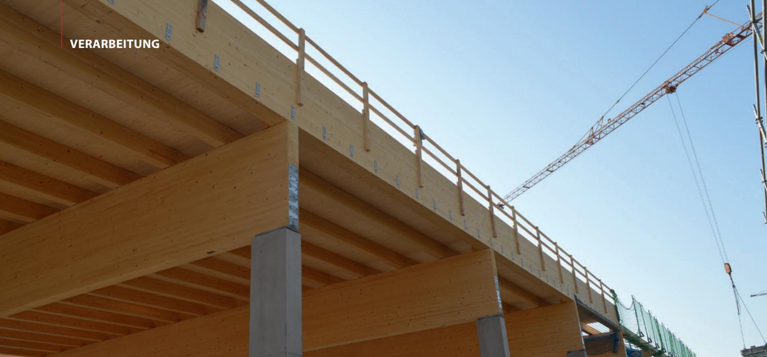
Für die Anschlüsse der Leimbinder beim Bau des Hallenbades in Ried wurden speziell beschichtete Ricon-Verbinder eingesetzt, die auch stark korrosiver „Hallenbadluft“ widerstehen können
