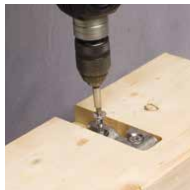
3) Vissage des ferrures.
