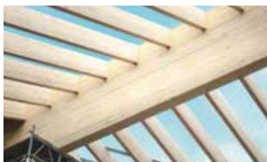
Toiture de hall de la charpenterie S. Hinrichsen (DE)
