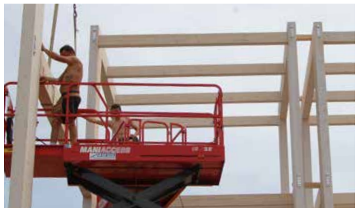
Montage d'une structure poteaux - poutres avec RICON®S
