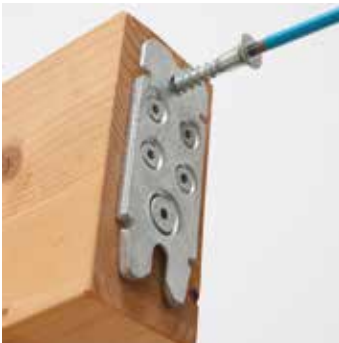
3) Vissage des ferrures.
