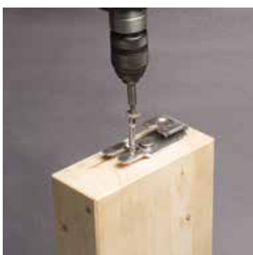
5a) Vissage des ferrures.
