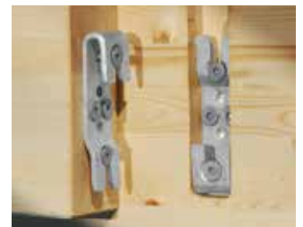
Exemple de mise en oeuvre : Encastrement sur poutre principale.
