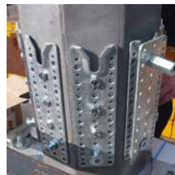
Noeud d'assemblage pour dôme
