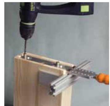
2) Positionnement et pré-perçage avec le gabarit de perçage.
