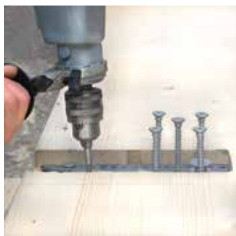
3) Vissage sur la poutre principale.
