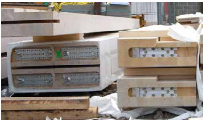
RICON® S encastré en bout de poutre secondaire, non visible sur 3 côtés
