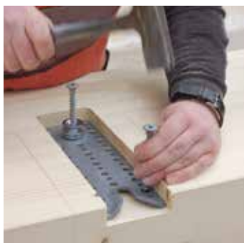
2) Positionnement des ferrures et vis
