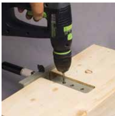
2) Pré-perçage avec le gabarit de perçage sur poutre principale
