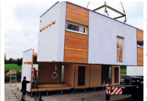
Jonction très rapide d'éléments modulaires.
