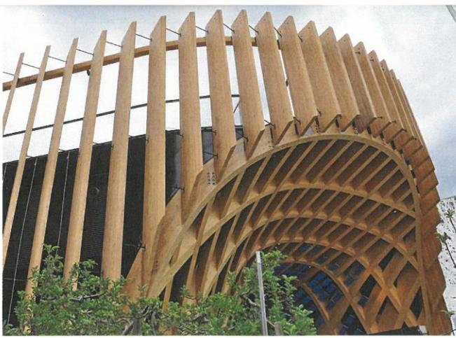
Gekrümmte Brettschichtholzträger bilden die Decke der Markthalle und gleichzeitig das Tragwerk für darüberliegenden Ebenen.
