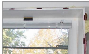
**Fixation :** Par vissage, clouage ou collage en direct sur la face ou dans une rainure.
