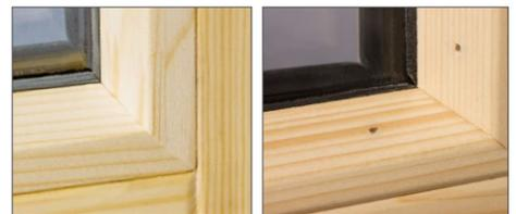
Nouvelle méthode avec FIXclip-Barre (aucun clou visible).
