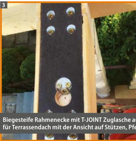
Biegesteife Rahmenecke mit T-JOINT Zuglasche aus Furnierschichtholz für Terrassendach mit der Ansicht auf Stützen, Pfette und Sparren.
