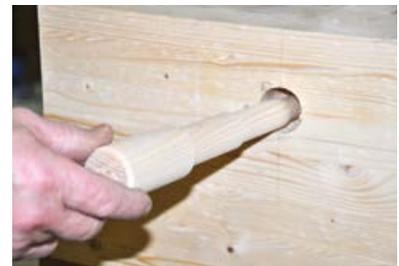
Einsetzen bis zum Nagelkopf.
