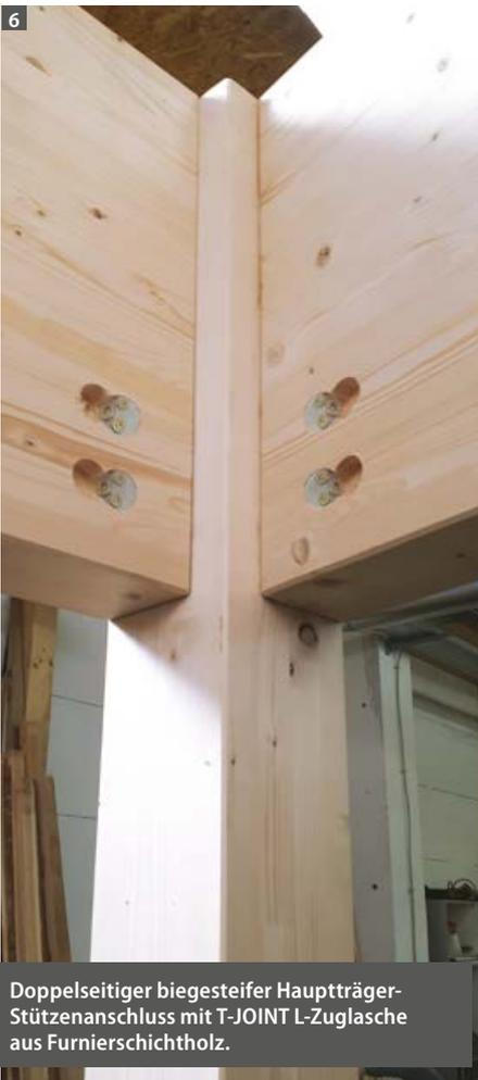
Doppelseitiger biegesteifer Hauptträger-Stützenanschluss mit T-JOINT L-Zuglasche aus Furnierschichtholz.
