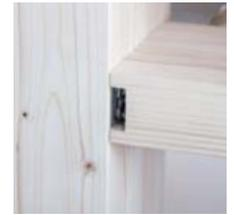
Gesicherte Verbindung durch Sperrbügel
