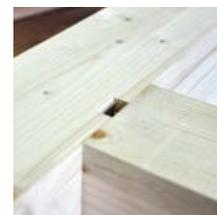
Gesicherte Verbindung durch Sperrbügel
