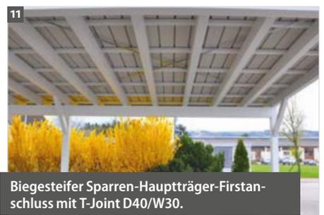
Biegesteifer Sparren-Hauptträger-Firstanschluss mit T-Joint D40/W30.
