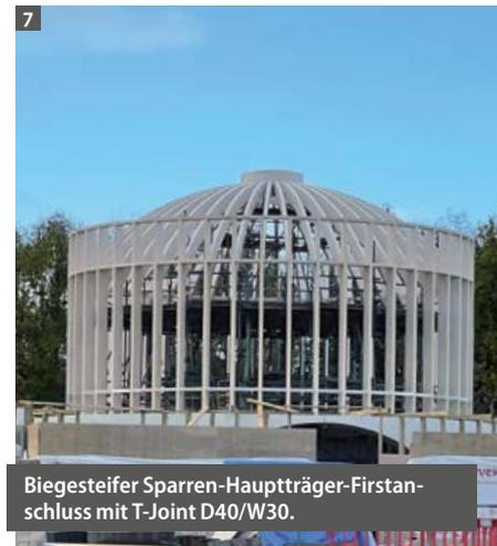
Biegesteifer Sparren-Hauptträger-Firstanschluss mit T-Joint D40/W30.
