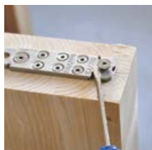
Montage de la goupille de verrouillage
