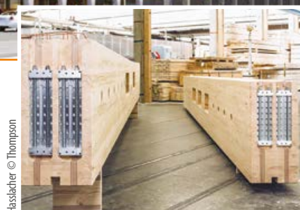
Exemple de montage - MEGANT® encastré en bout de poutre : pas d'affaiblissement de la poutre principale.
