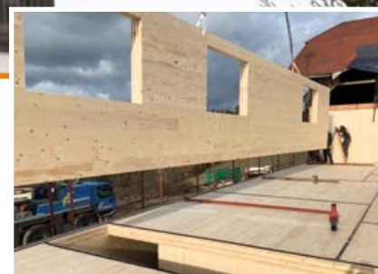
Exemple de montage : jonction de murs CLT.
