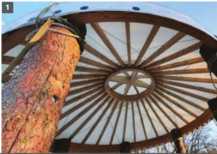
1 Assemblages biais de chevrons vissés sur un dôme avec T-JOINT.
