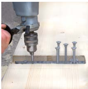
Vissage de RICON® S sur la poutre principale.
