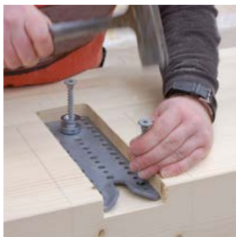
Positionnement des ferrures et vis
