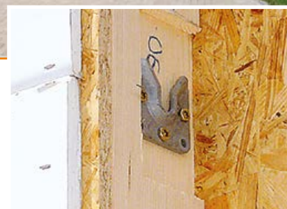
Exemple de montage : ferrure encastrée sur un montant
