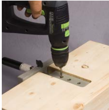
Pré-perçage poutre principale
