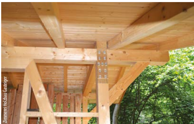
T-JOINT D35/W30 fixé sur les plaques en bois dur pour des jonctions LC.
