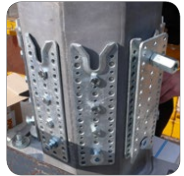
Firstknoten für Kuppeldach
